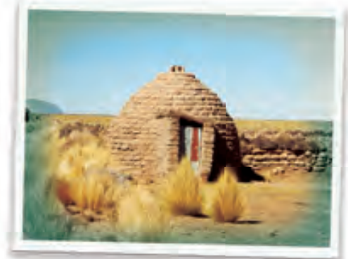
Los Chulpas o Putucus en el altiplano suramericano construyeron sus hogares con base en la catenaria invertida.
